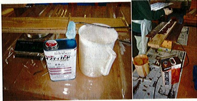
図 1-1 ローラー刷毛による表面処理の様子
