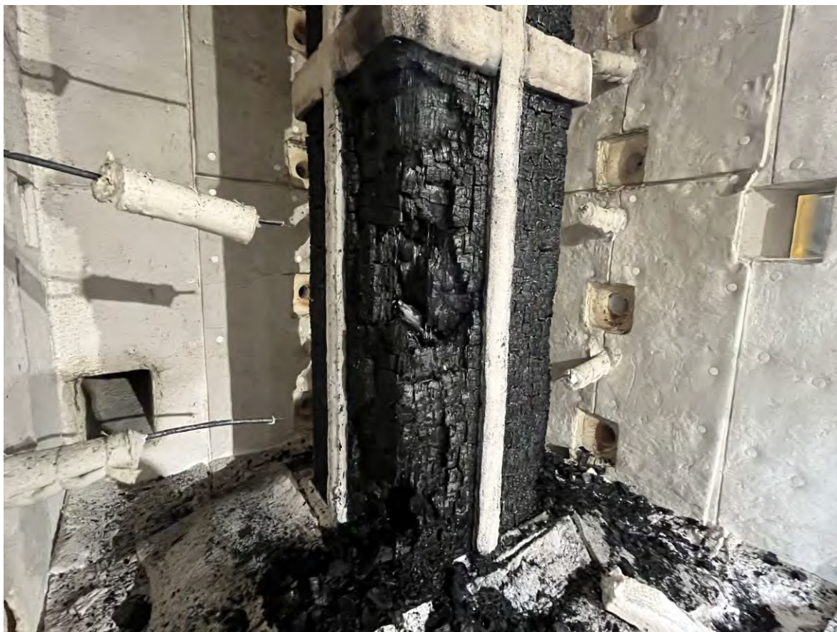
写真 4-22 脱炉後 仕様④ 下半分
