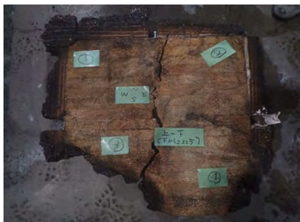
写真-18 試験体A 上半部下部断面 (下から2225mm) (解体後)
