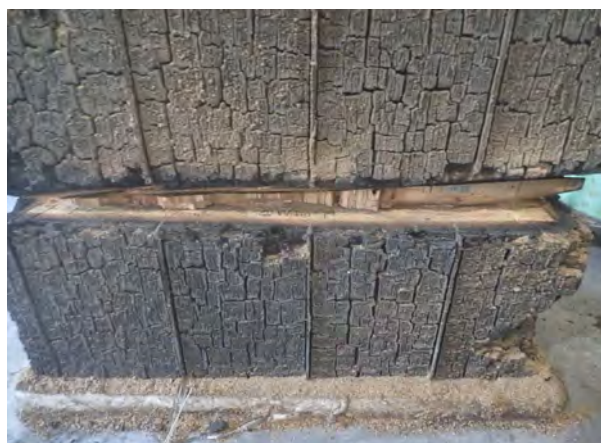
写真-44 仕様2 W面側 (解体後)
