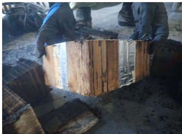
写真-54 仕様4 上から500mmの断面の荷重支持部材側面 (解体後)
