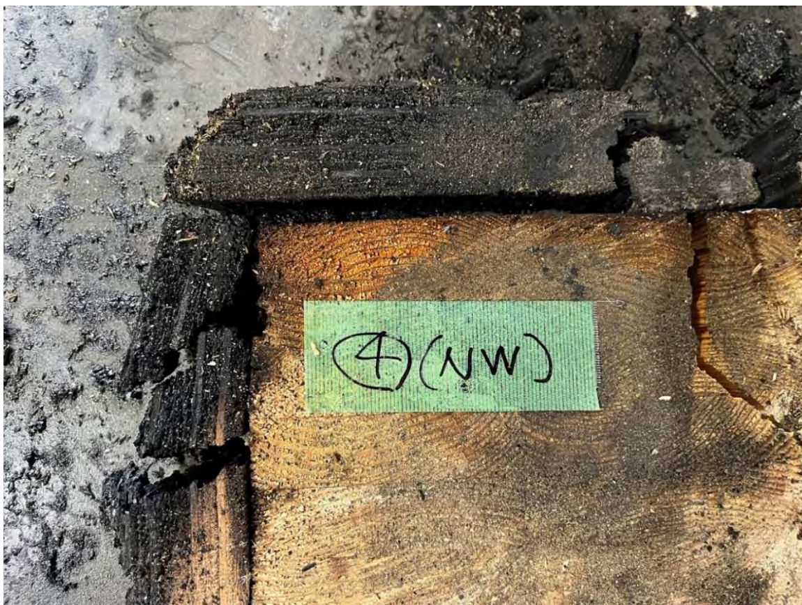
写真 4-64 断面 仕様④ 下半分の下側
