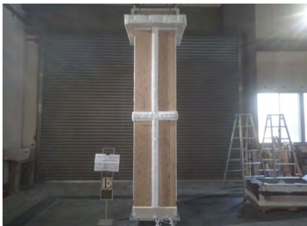
写真-1 試験体A E面側 (加熱前)
