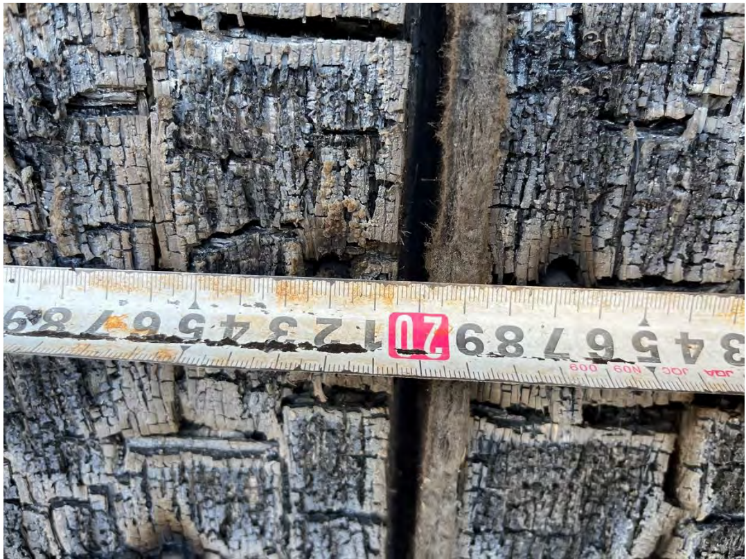
写真 4-77 仕様③-2 NE 面 勝ち側目地
