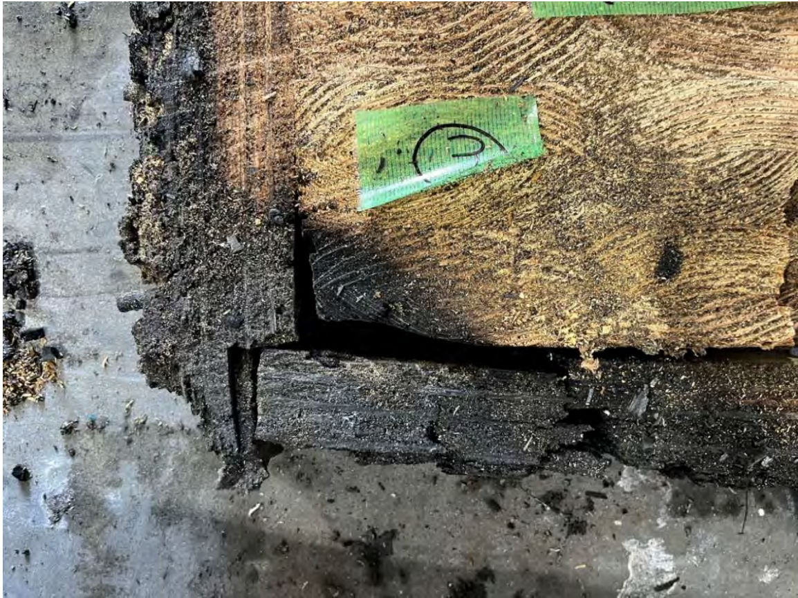
写真 4-66 断面 仕様③ 下半分の下側
