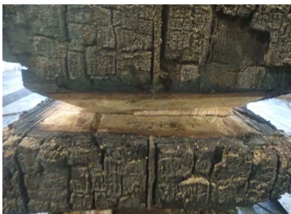
写真-43 仕様2 N面側 (解体後)
