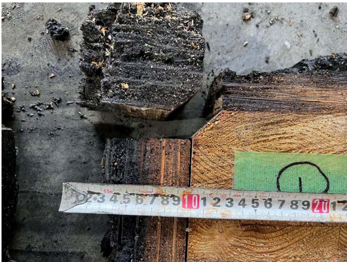
写真 4-79 断面 仕様① 上半分の上側
