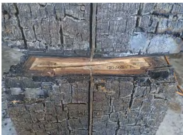
写真-45 仕様2 S面側 (解体後)
