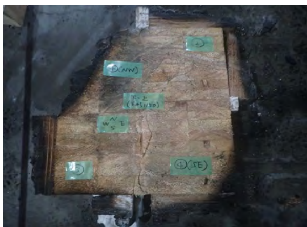
写真-19 試験体A 下半部上部断面 (下から1150mm) (解体後)
