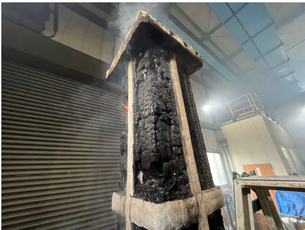
写真 4-39 SE 面 仕様④ 上半分
