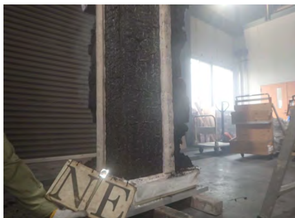
写真-16 試験体A 下半部NE面側 (加熱後)
