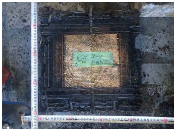
写真-48 仕様3-1 上から500mmの断面 (解体後)
