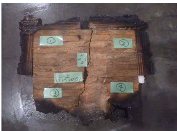
写真-17 試験体A 上半部上部断面 (下から2675mm) (解体後)
