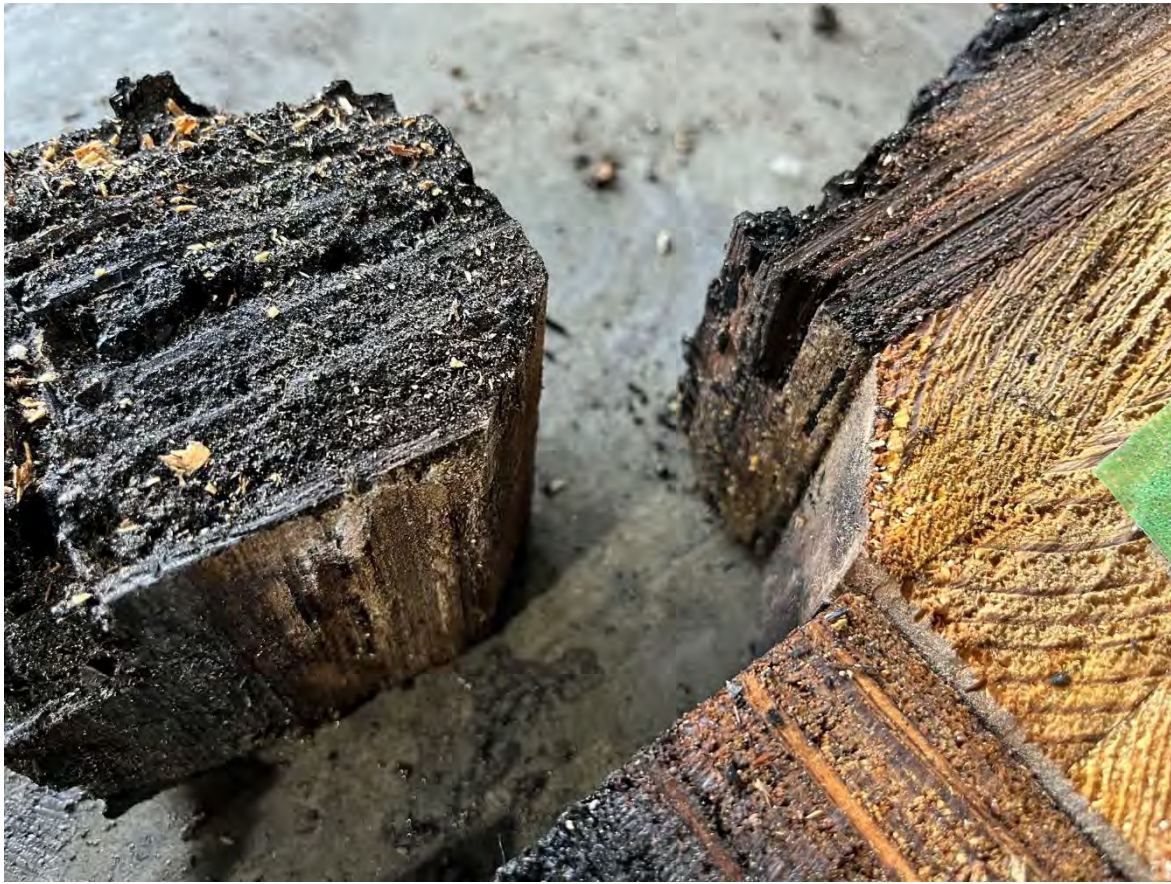
写真 4-81 断面 仕様① 上半分の上側
