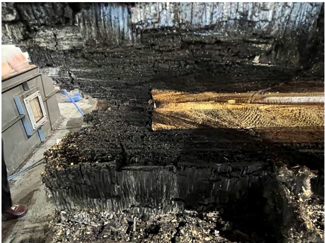
写真 4-32 仕様① N面 上部
