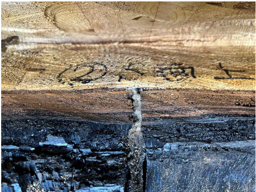
写真 4-44 仕様② S面 上部
