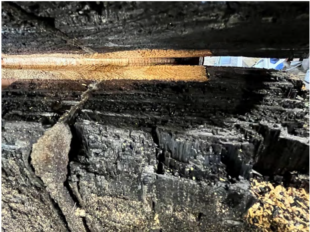
写真 4-31 仕様① N面 上部
