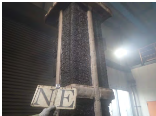
写真-12 試験体A 上半部NE面側 (加熱後)
