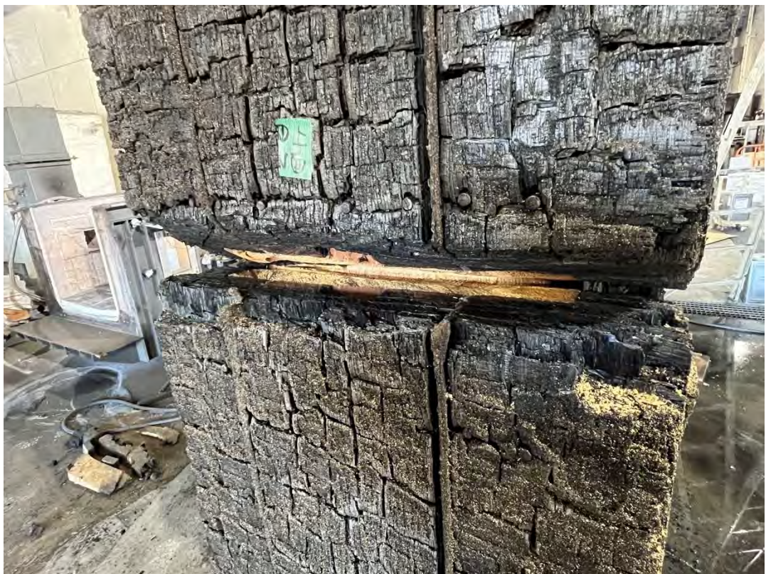
写真 4-30 仕様① N面 上部
