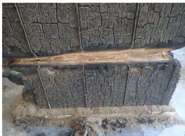
写真-46 仕様2 E面側 (解体後)
