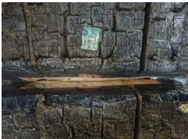
写真-41 仕様1 N面側 (解体後)
