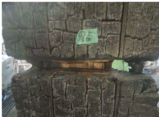
写真-42 仕様1 S面側 (解体後)
