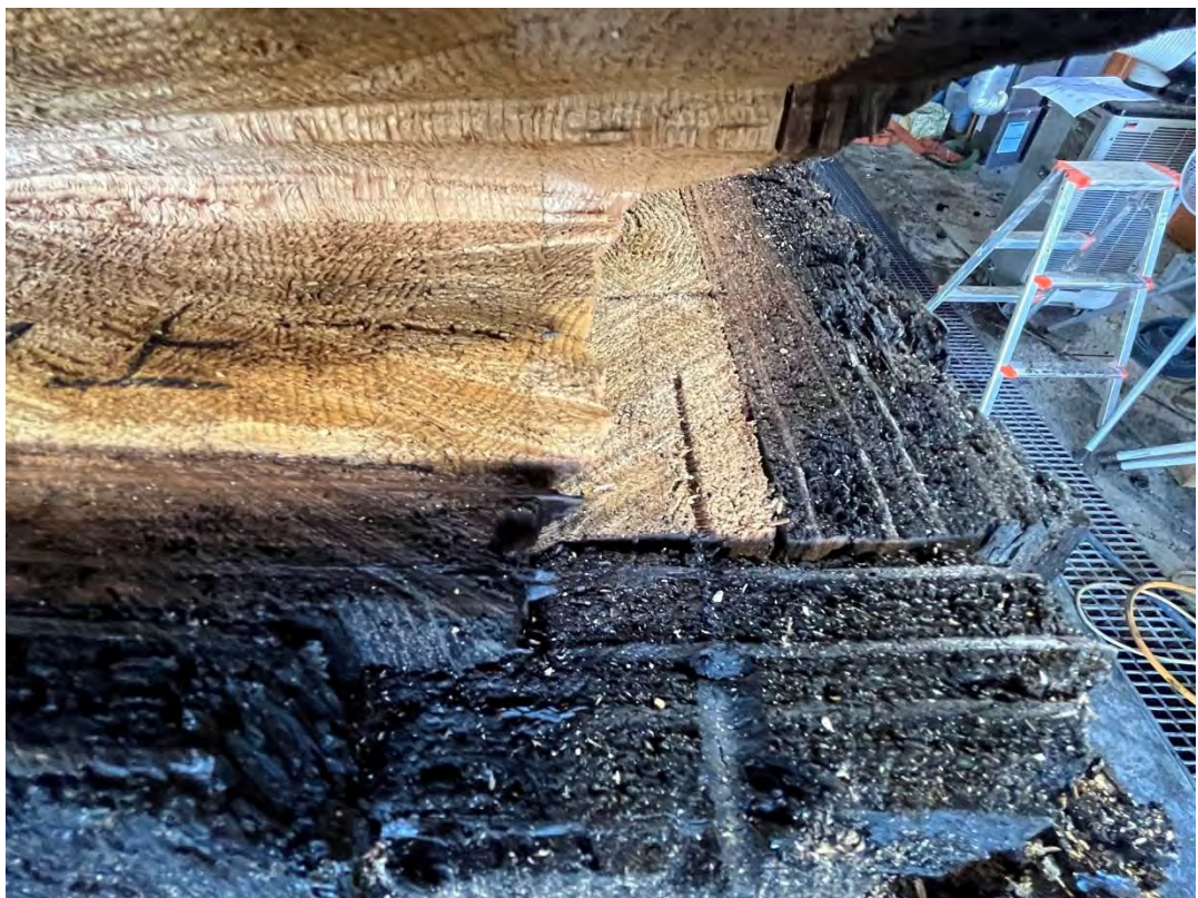
写真 4-45 仕様② S面 上部
