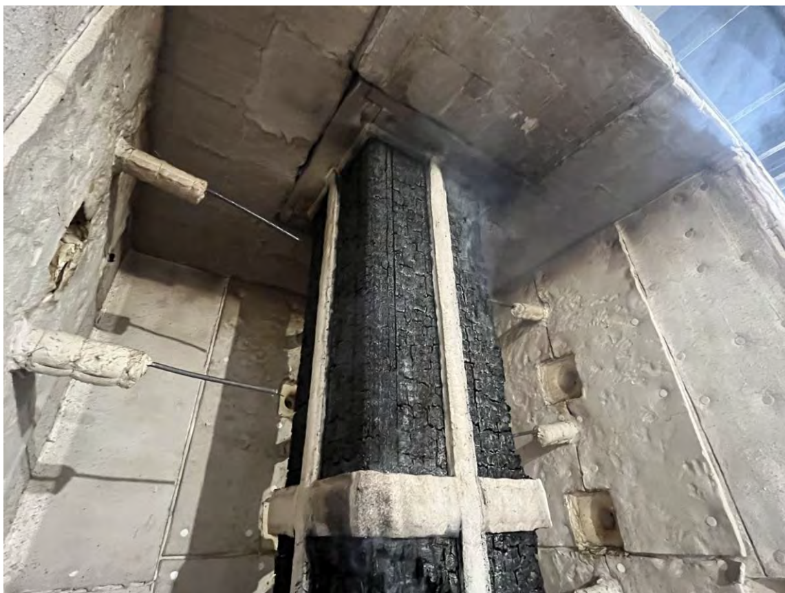
写真 4-21 脱炉後 仕様①
