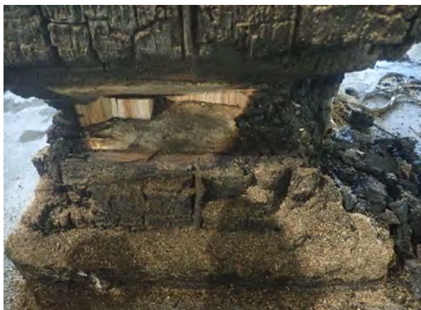
写真-47 仕様2 S面側下部 (解体後)
