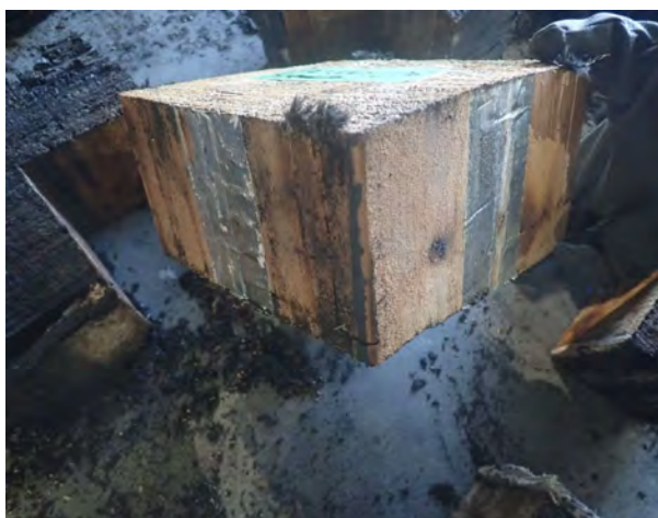
写真-55 仕様4 下から500mmの断面の荷重支持部材側面 (解体後)
