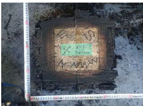
写真-49 仕様3-1 下から500mmの断面 (解体後)
