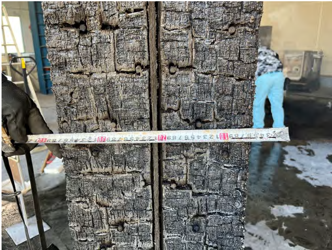
写真 4-64 仕様③-1 NW 面 勝ち側目地
