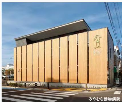
設計当時、大臣認定を取得するためにLVLの耐火実験が進められていて、このプロジェクトは採用第一号として最適な規模と条件で、LVL木層ウォールと在来軸組構法を併用して実現しました。LVL木層ウォールの施工時における苦労は主に3つありました。1つ目は建て方時の精度、基礎との取合いは1mm精度を要求され、LVLパネルを基礎へ取付ける際のアンカーボルトはコンクリートに予め打込まず、ケミカルアンカーを後打ちすることになりました。2つ目は設備配置、構造用LVLに孔をあげて通すといったことや設備を埋め込むことが困難であるため、配線スペースの天井を下げて確保したり、金属の配線ラックを別で取付けたりする等の対処を行いました。3つ目はLVLの塗装で、南面のLVL木層ウォールや仕上げ用LVL(キアラムインテリア)にはラミナの積層面が表面に見えるものを使用しましたが、塗装前の表面がささくれて手に刺さってしまう点に苦労しました。在来軸組部分の被覆については、耐火被覆は厚さ12.5mmの強化せっこうボードを使い、待合室に面する斜め壁ではそのせっこうボードの上に仕上げ用LVLを貼っています。
