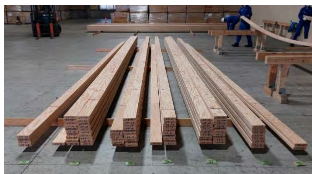
写真 2.3-2 二次接着 接着剤塗布
