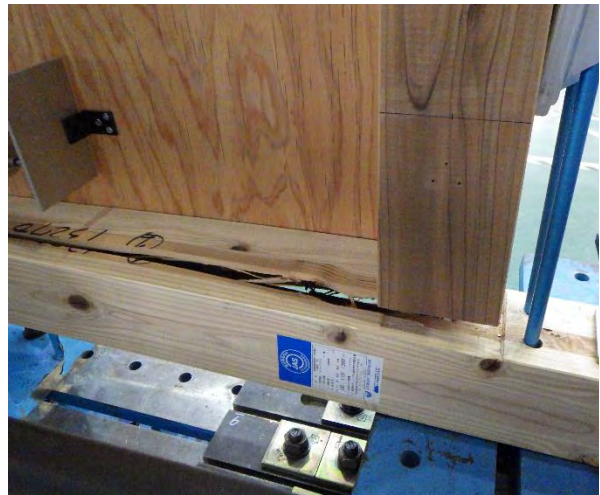
写真3.3.3.8 試験体の状況（試験後） 試験体名：接着剤無
