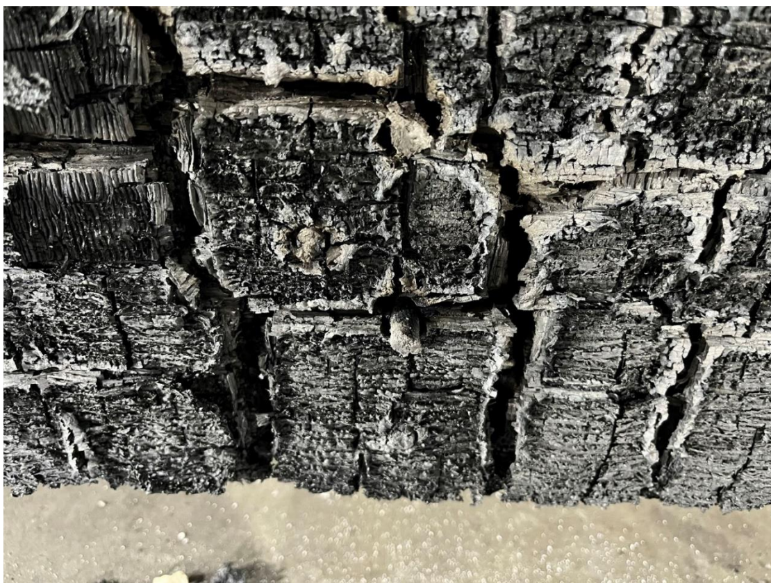
写真 3-3-29 試験後被覆材の木栓の所
