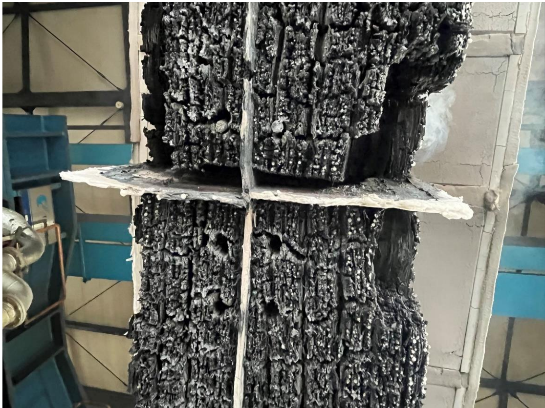
写真 3-5-11 脱炉試験後（底面）
