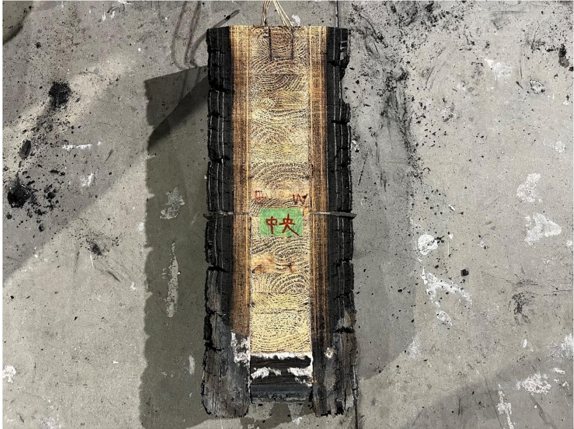
写真 3-4-21 梁断面（中央部）
