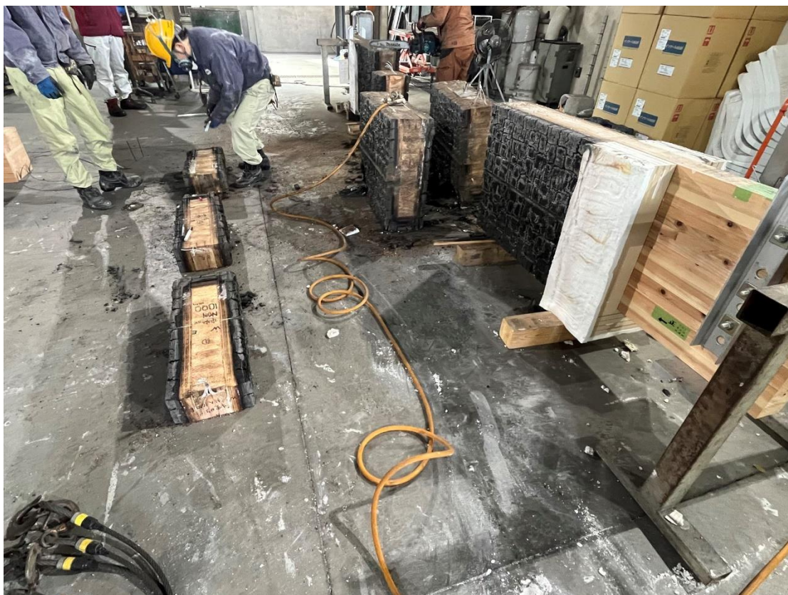
写真 3-3-32 各断面 切断後
