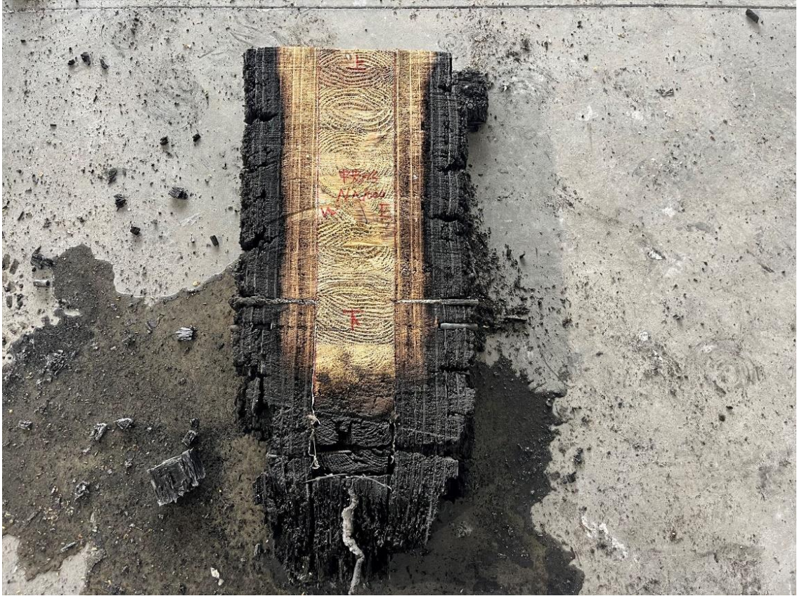
写真 3-5-21 被覆材炭化部
