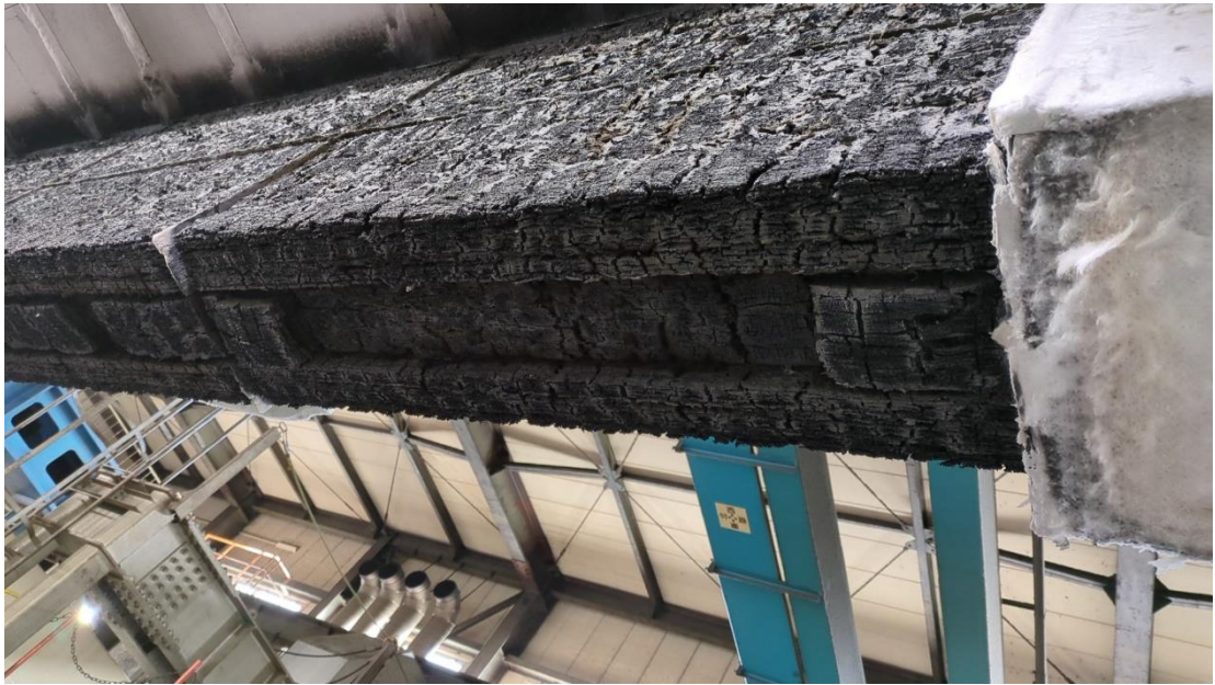
写真 3-4-11 脱炉試験後（底面）
