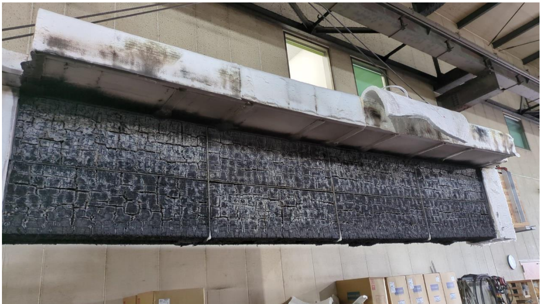
写真 3-4-10 脱炉試験後（側面）
