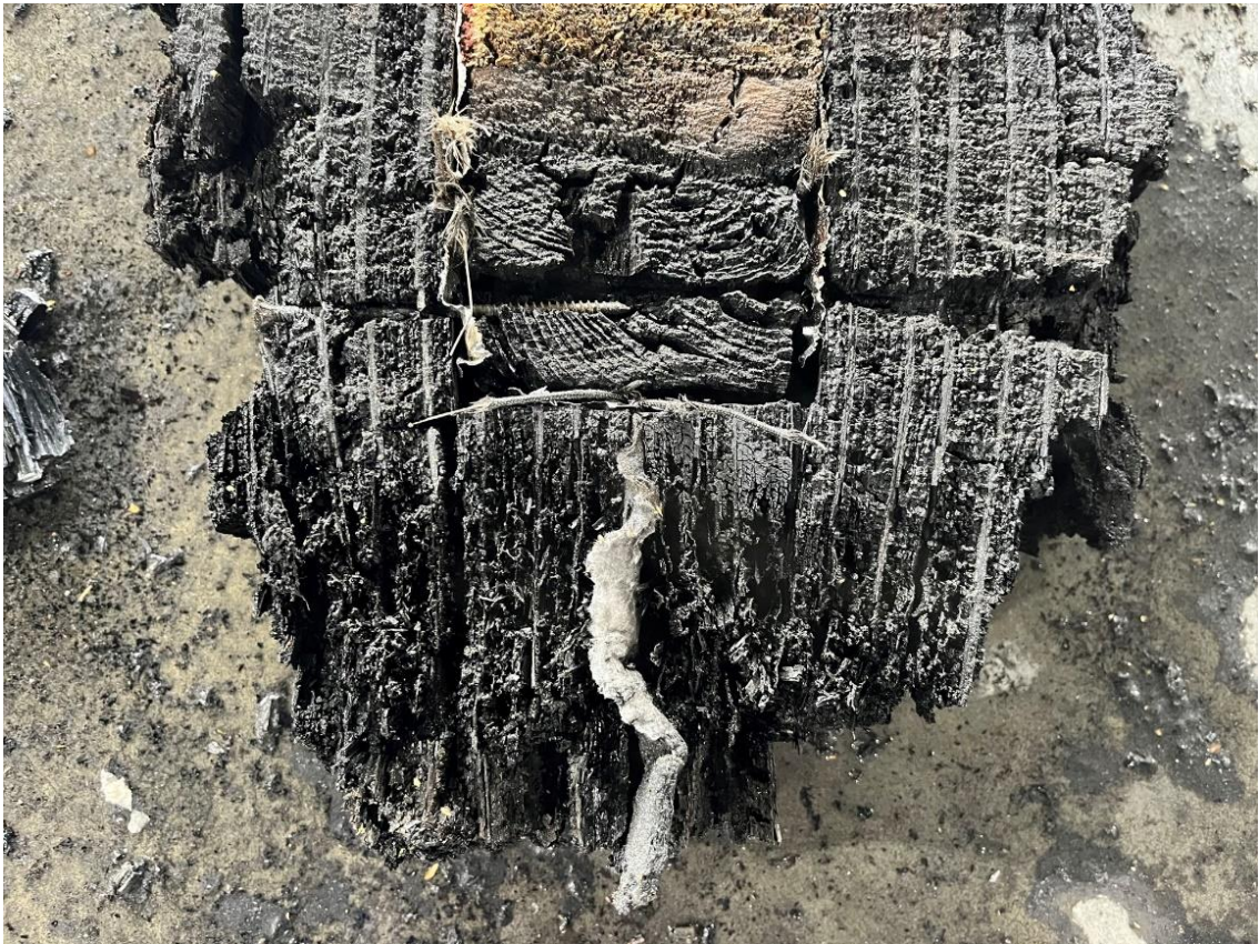
写真 3-5-22 梁断面（中央部）
