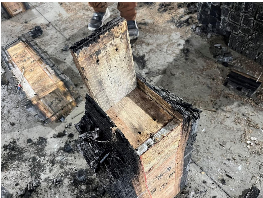
写真 3-3-38 荷重支持部の炭化確認（中央部）
