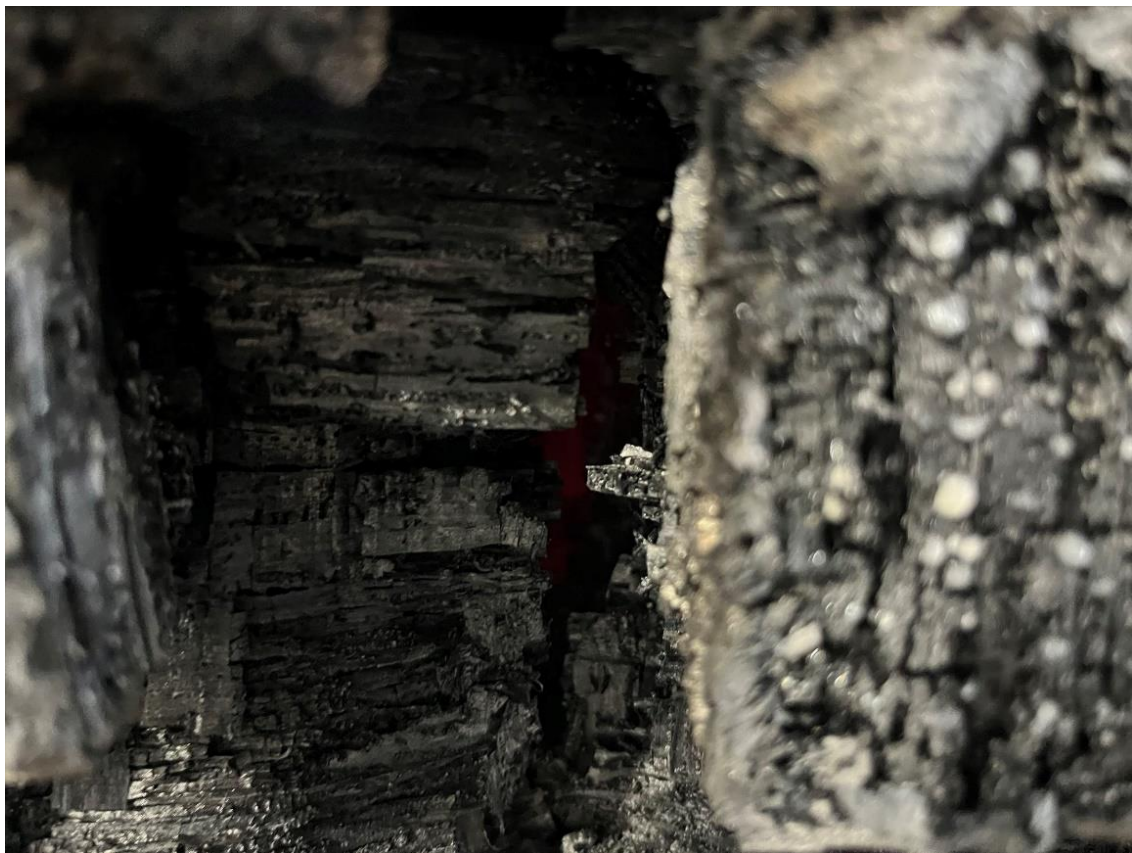
写真 3-5-20 梁断面（中央から N 側に 1000mm）
