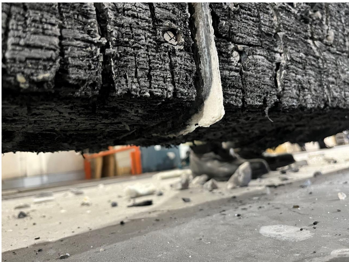
写真 3-4-14 側面底面（目地）
