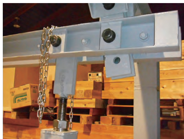
写真 2 アーム支点部
