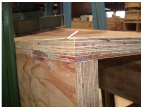
部材間ずれの発生なし（試験体 3）
