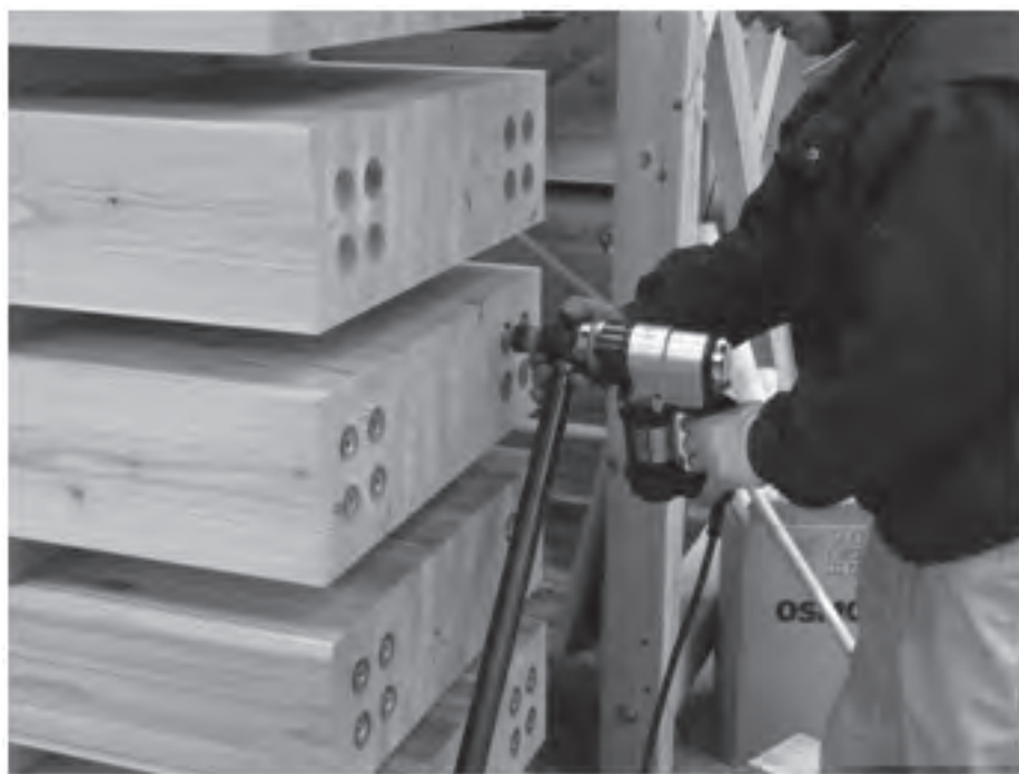
写真1 LSBの施工状況
