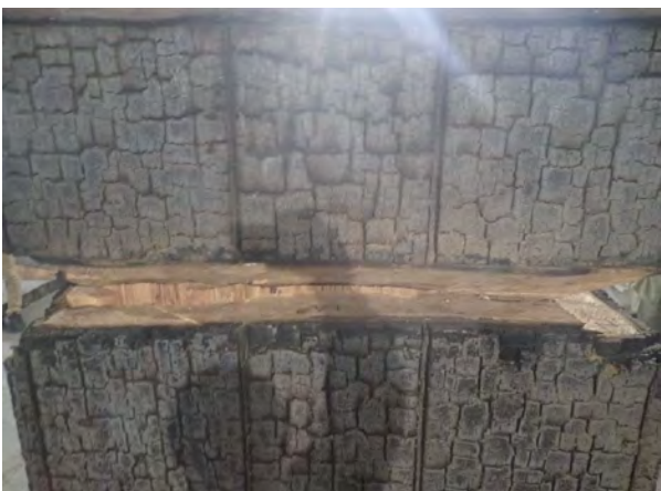
写真-11 試験体A NE面側(上段) (解体後)
