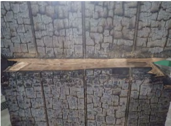
写真-15 試験体A SE面側(上段) (解体後)
