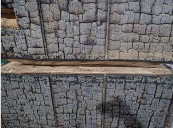
写真-13 試験体A SW面側(上段) (解体後)
