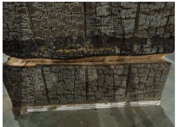
写真-28 試験体B E面(N側) (解体後)
