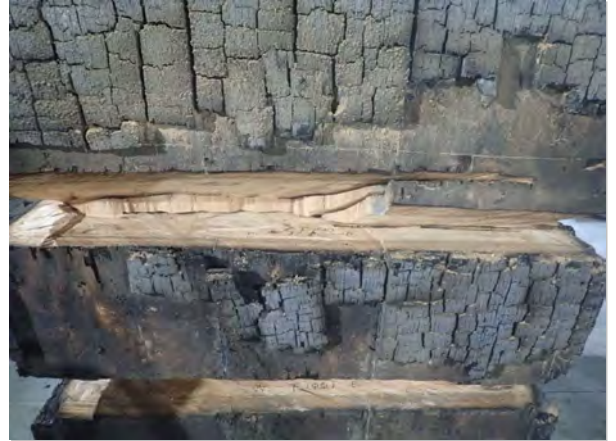
写真-32 試験体B 下面(S側) (解体後)
