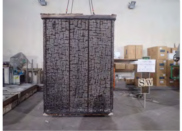
写真-8 試験体A SW面側 (加熱後)
