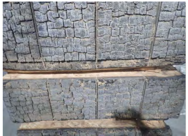
写真-30 試験体B W面(中央) (解体後)
