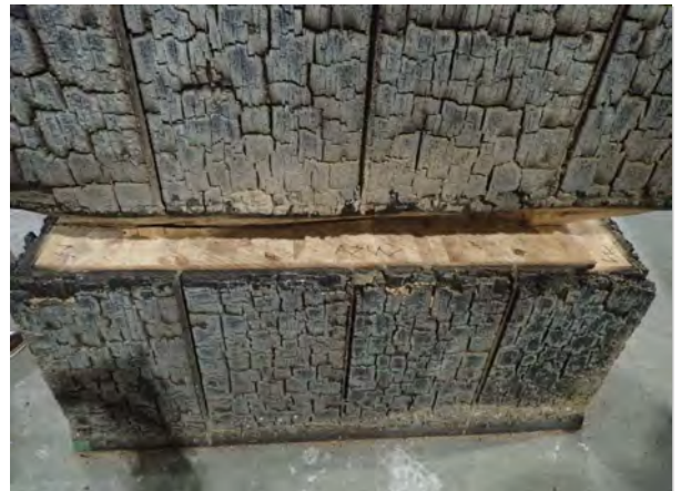
写真-10 試験体A NW面側(下段) (解体後)
