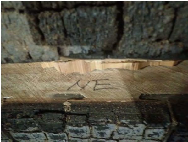
写真-19 試験体A NE側平部 (解体後)
