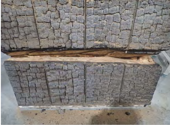
写真-31 試験体B W面(N側) (解体後)
