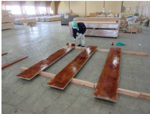
写真 2.2.2 レゾルシノール樹脂塗布
