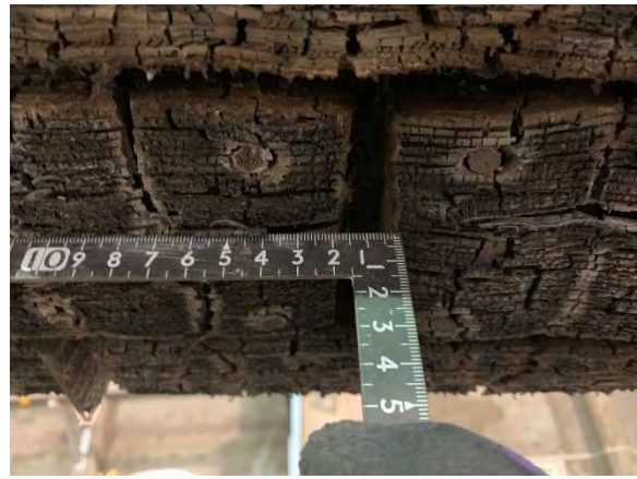
写真 4-14 下面目地開き 18mm
