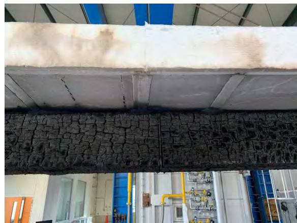
写真 4-16 側面目地北側
