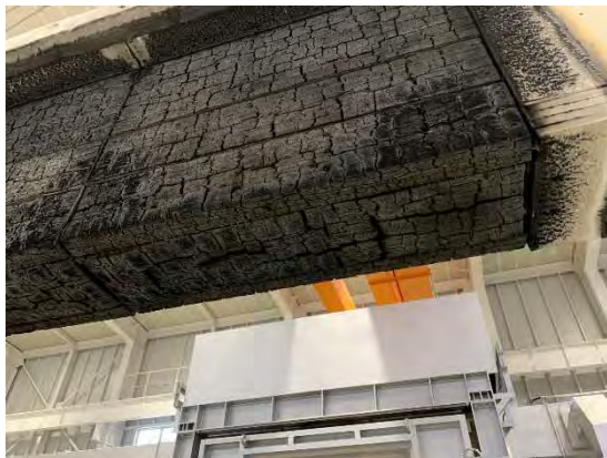
写真 4-18 被覆材下面（南側端）
