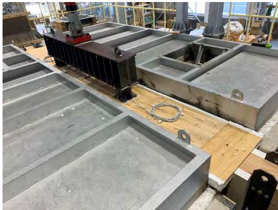
写真 4-3 加力治具設置 (被覆前)
