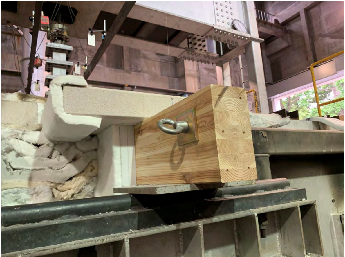
写真 4-4 端部支持状況
