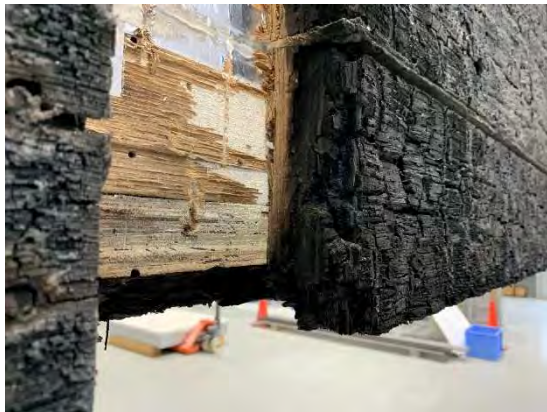
写真 4-52 梁下部隅部（西中間点）
