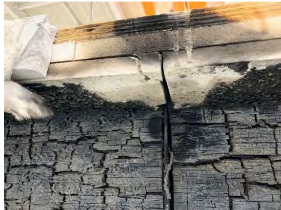
写真 4-25 床側面（南西側 1/4 点）
