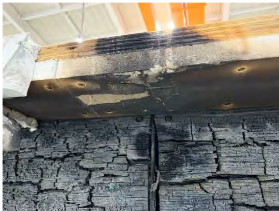
写真 4-26 床側面ボード 1 枚はがし（南西側 1/4 点）
