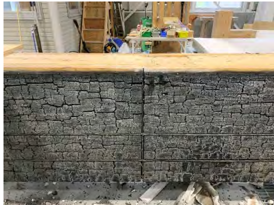
写真 4-33 被覆材目地 (南西側 1/4 点)
