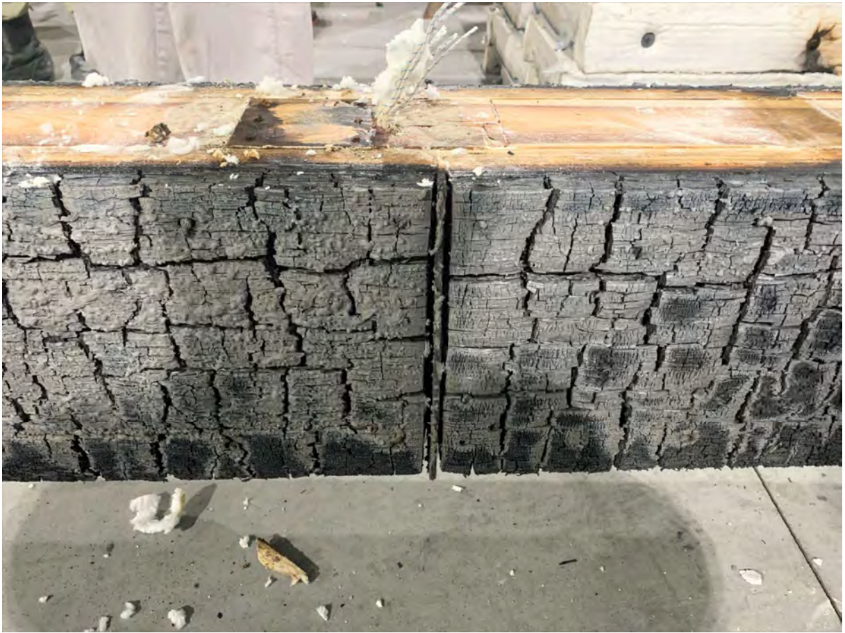
写真 4-21 側面 北西目地
