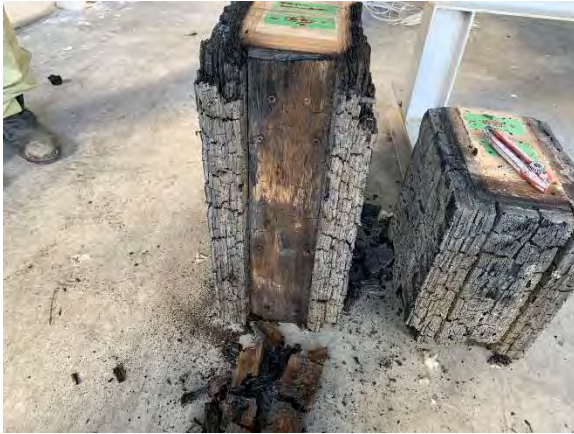
写真 4-29 梁下面 30mm 被覆を剥がし
