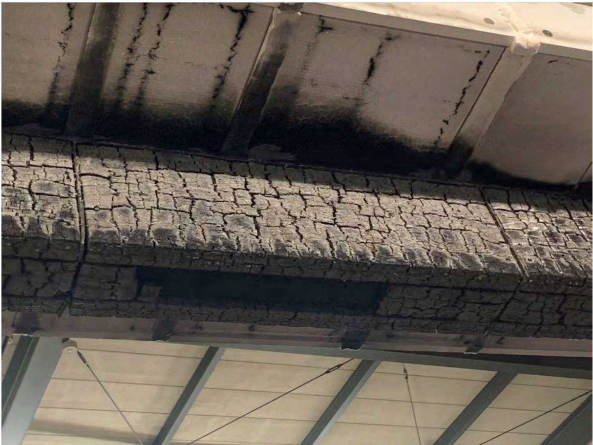
写真 4-10 下面の脱落
