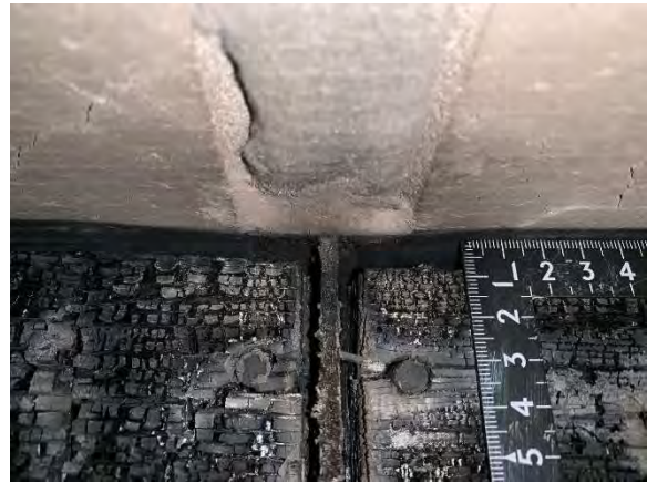
写真 4-16 側面と床の開き 8mm
