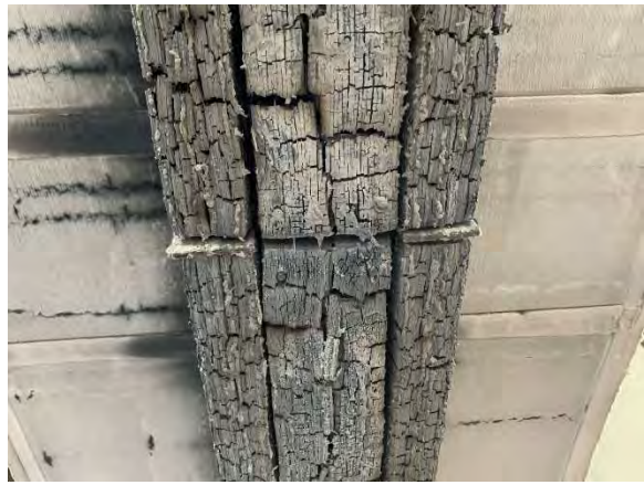
写真 4-20 下面目地中間点
