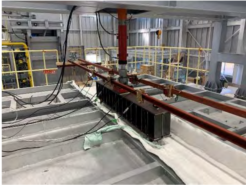
写真 4-9 変位計設置状況（加熱中）
