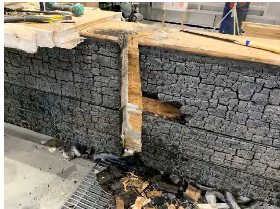
写真 4-41 被覆材はがし (西側中間点)
