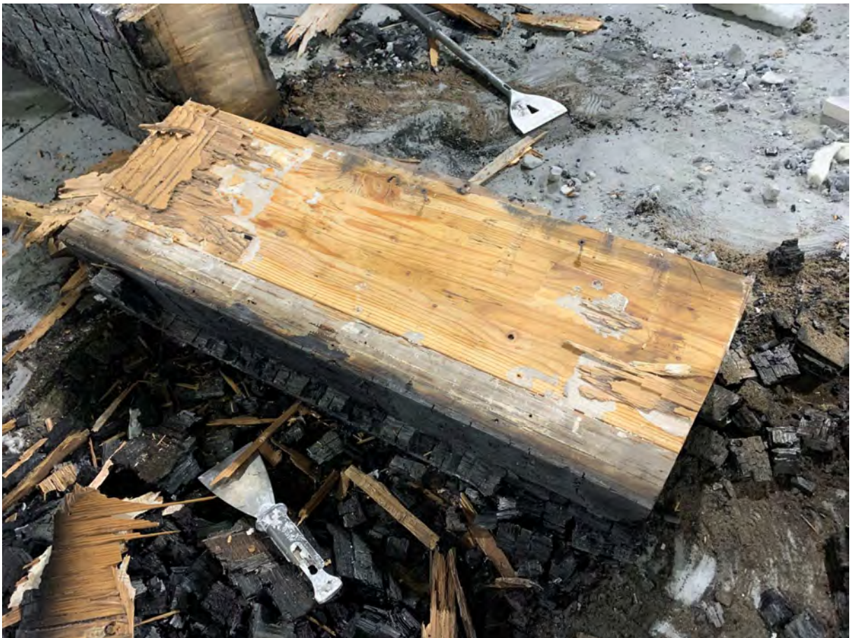
写真 4-24 荷重支持部材に炭化無し 側面南東部
