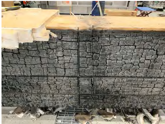
写真 4-40 被覆材目地 (西側中間点)
