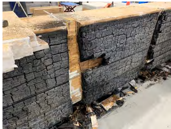
写真 4-43 被覆材はがし (西側中間点)
