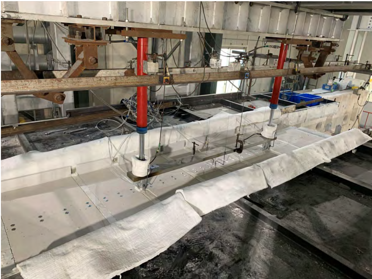
写真 4-2 端部被覆状況
