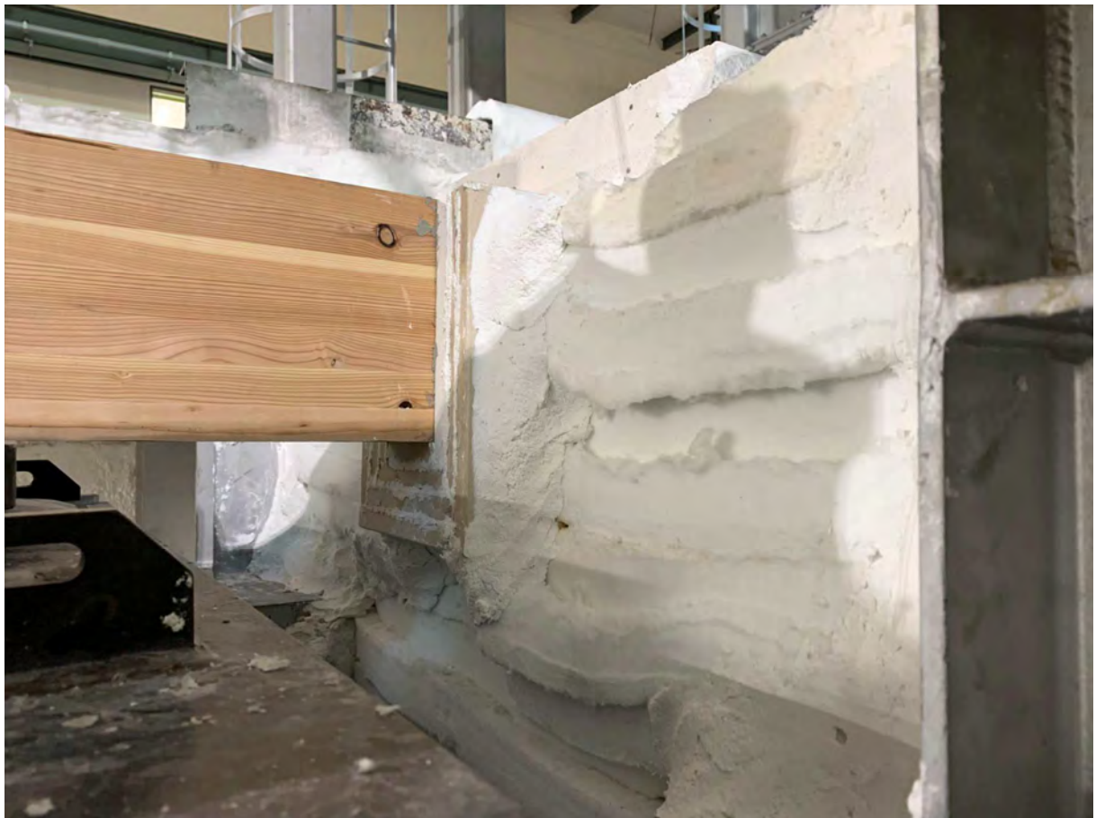
写真 4-4 端部支持状況
