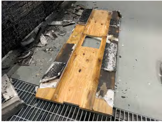
写真 4-30 床合板下面 (南側)
