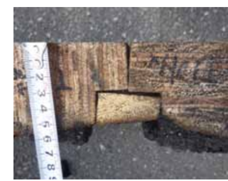
写真 5 厚さ 100mm 以上の非耐力壁の 60 分加熱後の炭化状況
