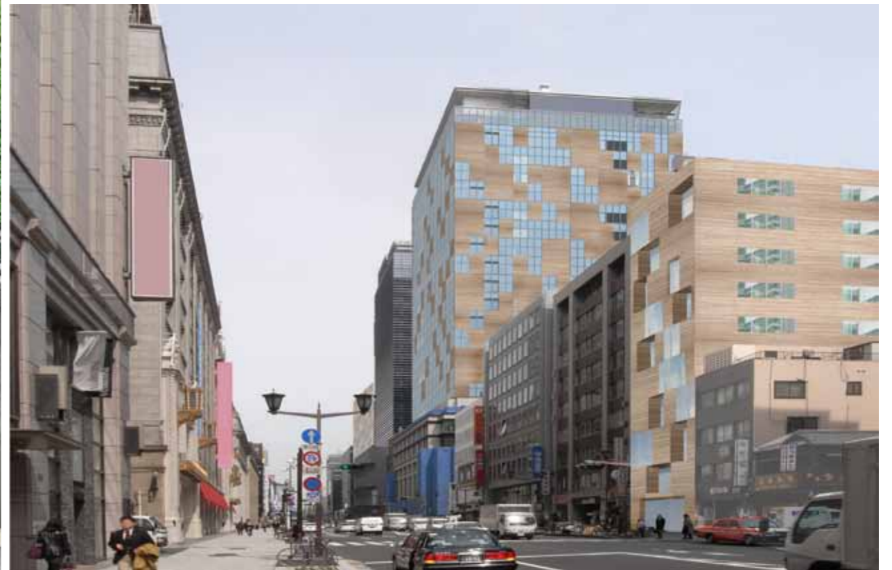
耐火建築物のビルの将来の開発イメージパース： ファサードを構成する「木層ウォール FP30」を使ったカーテンウォール（延焼のおそれのない部分に使用）
