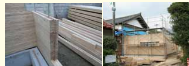
140mm × 90mm の LVL 材を現場で積み上げ、壁を構成する。
