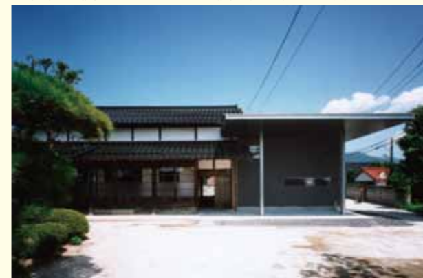
新旧の木の建築が共存したファサード
