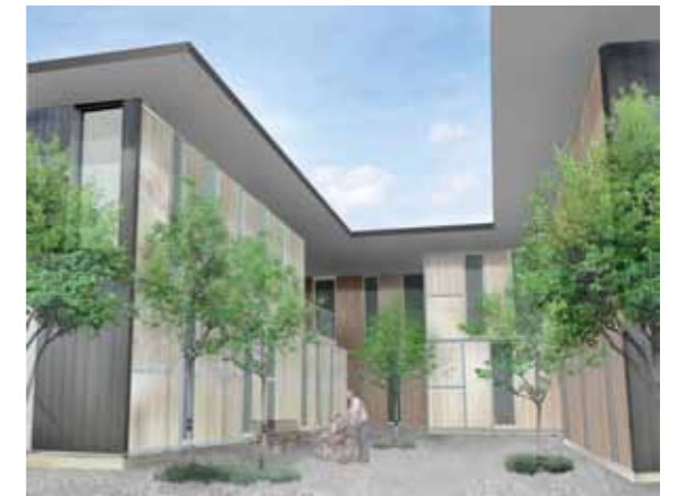
外観パース：深い庇が対面する中庭には、外壁に木の表情が見えるよう単板ガラスをはった仕様を採用。植栽等を施し、豊かな中庭空間を演出する。その他の外壁は、外装材にガルバリウム鋼板をはり、耐候性を確保している。
