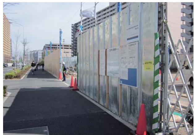
写真 3-2 鋼製仮囲い（手前）
