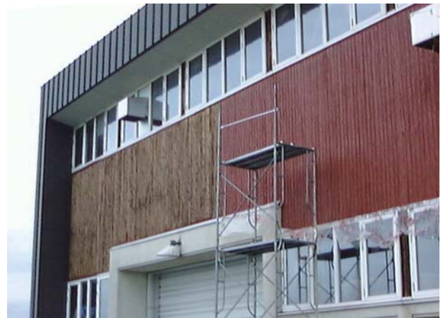
写真 5-2 経年劣化した外壁の塗装工事
