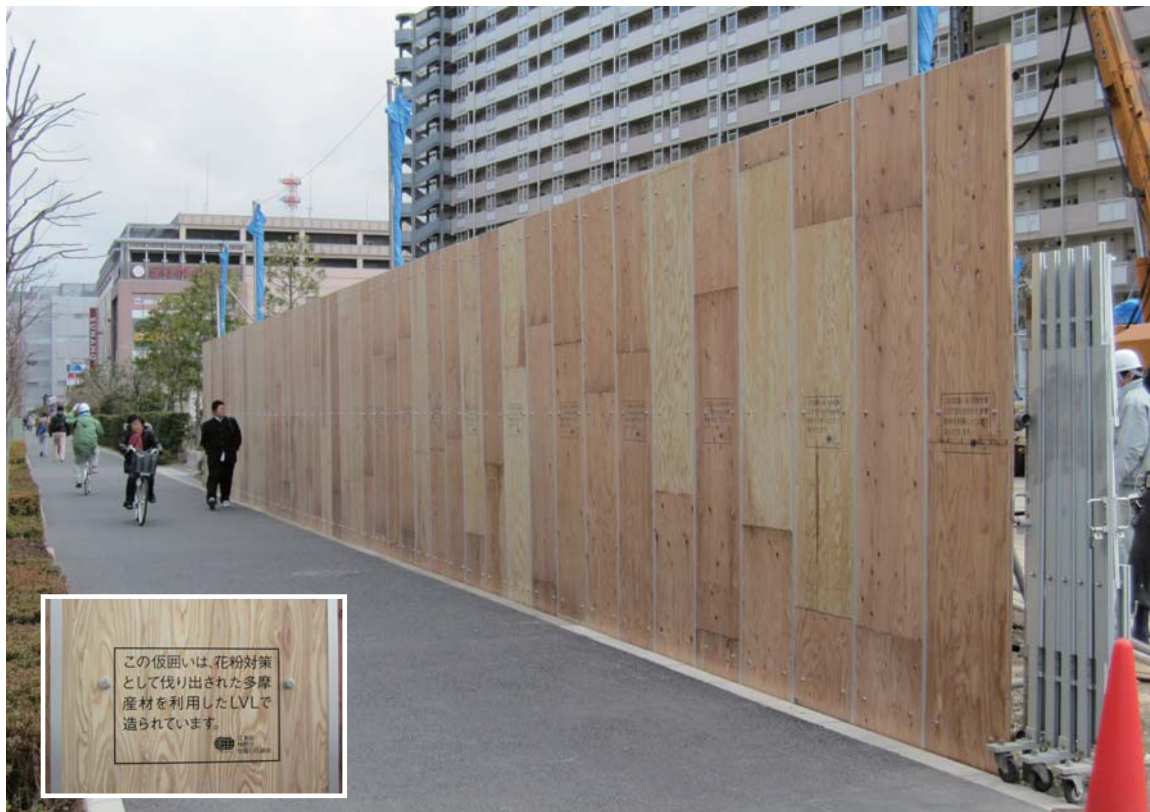
写真 3-1 LVLの仮囲い
