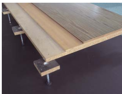
写真4-⑥-4 パーティクルボードの使用例(二重床)
