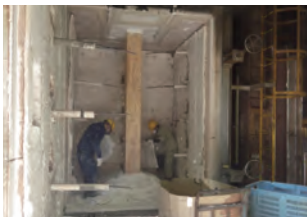
写真 7-1. 短柱による加熱実験の 試験体と耐火炉の様子
