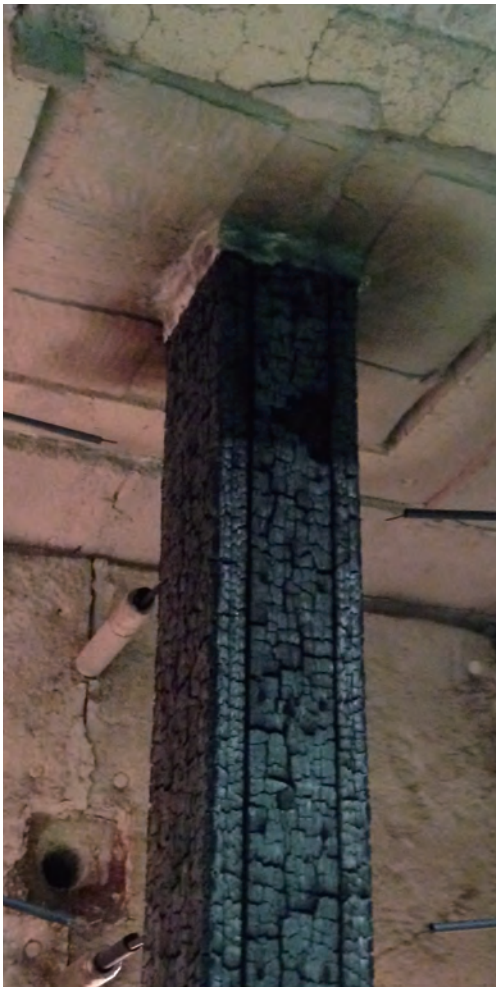
載荷加熱実験終了後の試験体 (3.5m 木製柱)
