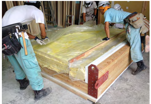
写真 8-2：断熱材敷き込みの様子
