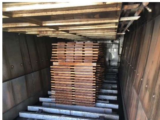
写真 3.2.8 乾燥窯に設置した LVL
