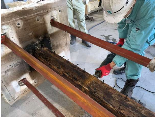
写真 4.3.2.31 荷重支持部材
