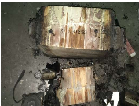
写真 4.2.2.14 被覆材接着状況
