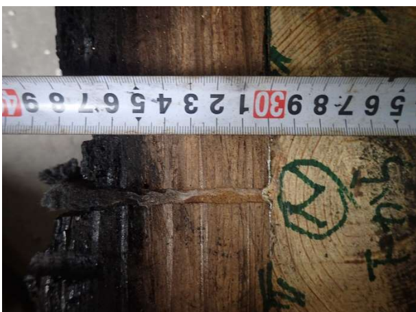
写真 4.2.1.12 柱上部の被覆材残存量
