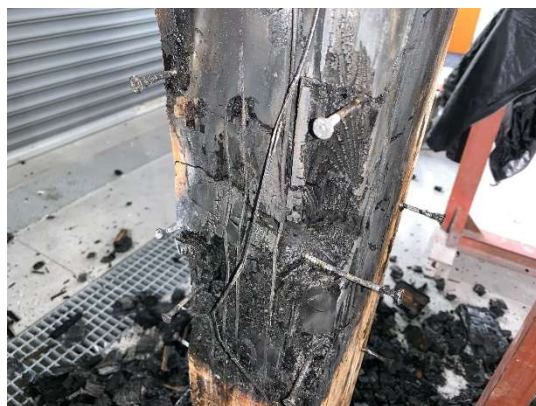
写真 4.3.2.25 柱炭化
