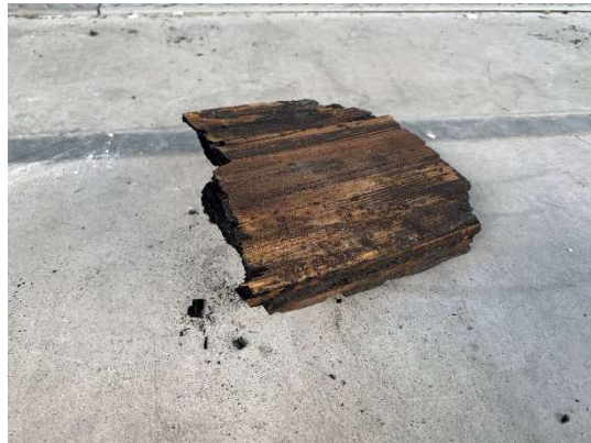
写真 4.3.2.30 被覆材裏側 (柱側)
