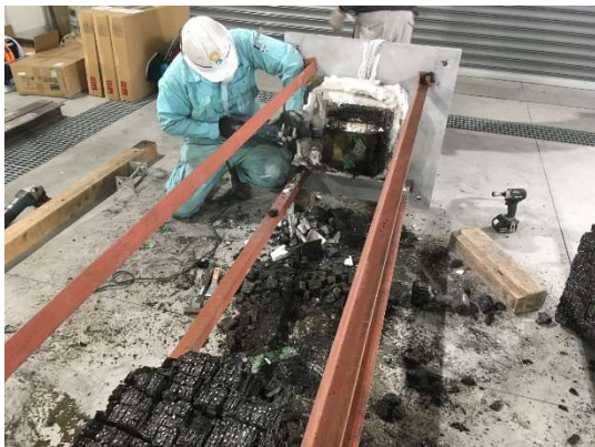
写真 4.3.1.18 柱最下部 切断
