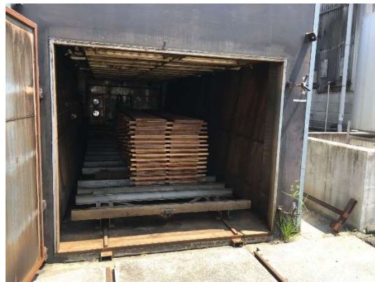
写真 3.1.8 乾燥窯に設置した LVL
