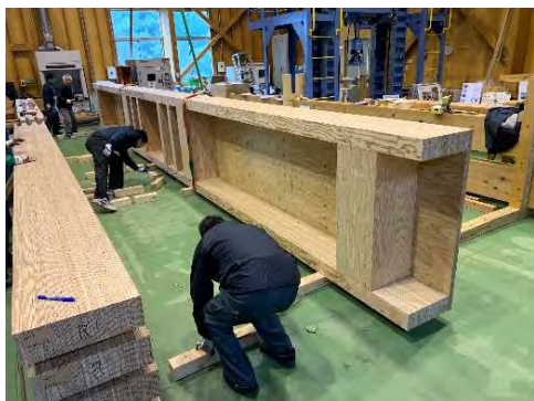
写真 2.3 ボックスビームの内部
