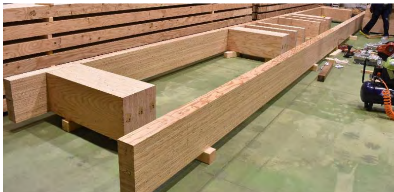
図 6.2-2 束材・支点補強材の位置決めの様子
