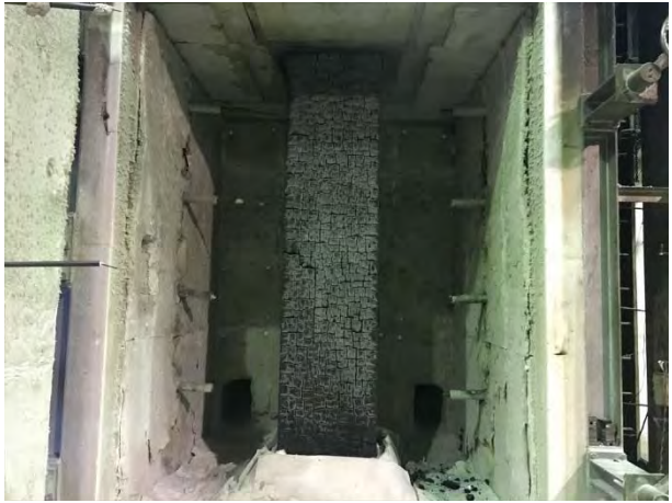
写真 4.2.2.3-2 試験体脱炉後の様子
