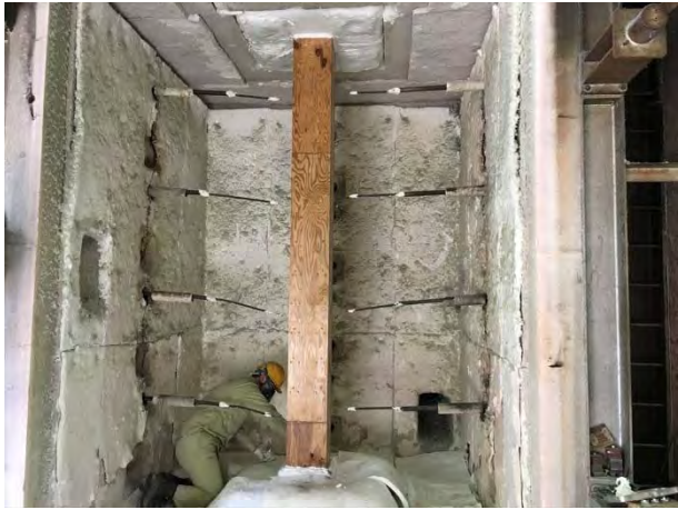
写真 4.3.1.3-1 試験体設置状況
