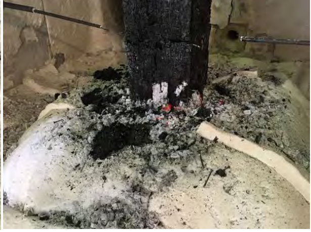
写真 4.4.1.3-8 被覆材の燃えカス
