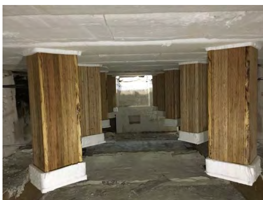
写真 4.1.1.1-1 炉内試験体設置の様子
