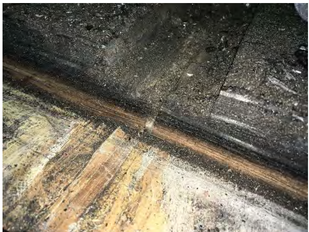
写真 4.2.3.3-12 北側中央部の炭化状況
