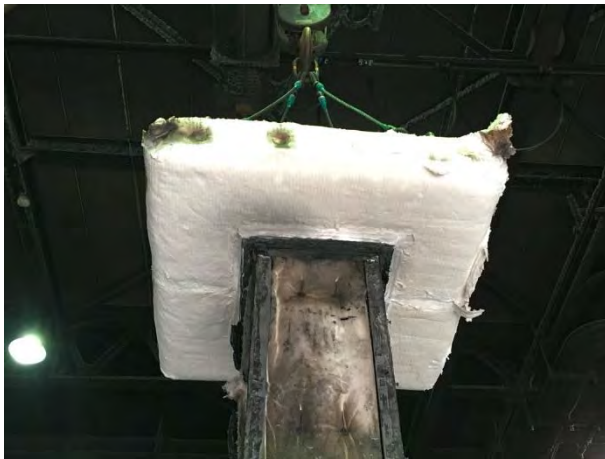
写真 4.4.2.3-9 脱炉後柱上部
