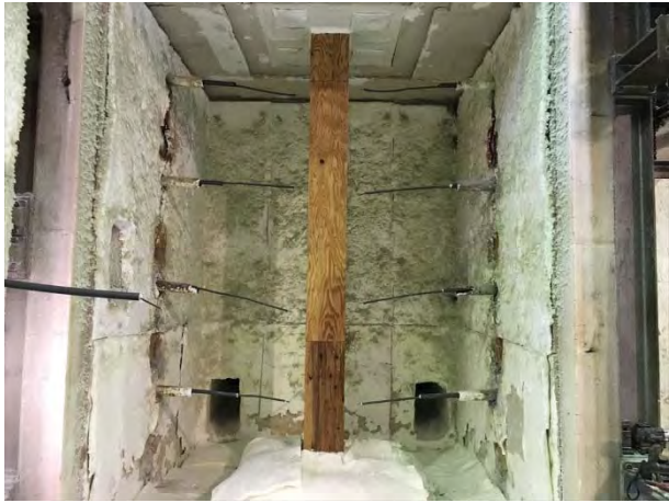
写真 4.3.2.3-1 試験体設置状況
