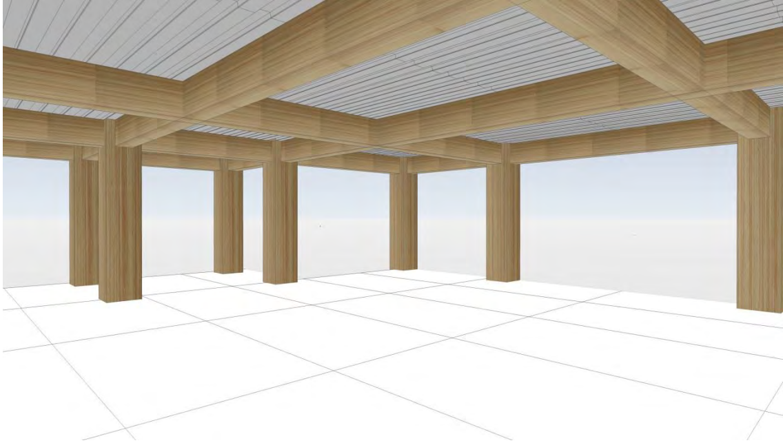
図 2.2-2 難燃処理単板積層材を用いた耐火建築物の内部
