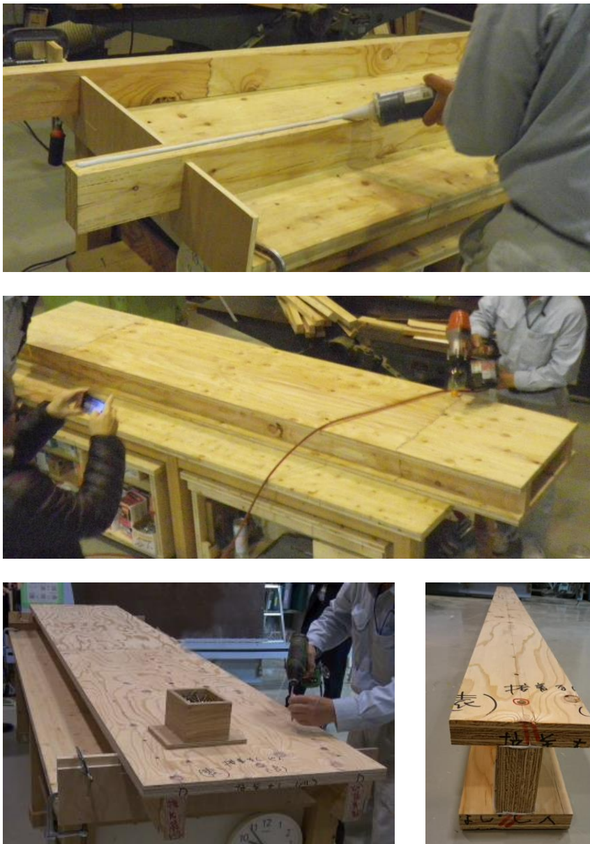
写真 6.2.1 実大試験体の制作状況
