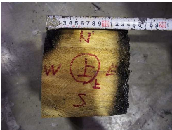
写真2.3.4-7 柱上部の炭化状況
