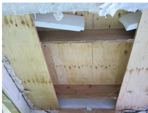
写真 2.1.3.8 LVL梁に炭化見られず
