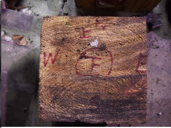
写真 2.3.4-10 柱下部の炭化状況
