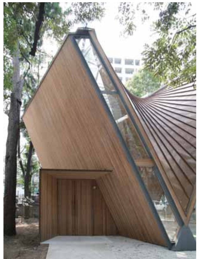
サブエントランス外観
