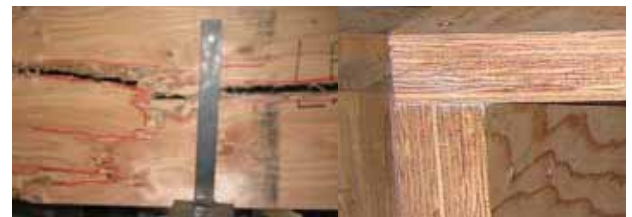
曲げ破壊 (左) およびウェブ端部の割裂なし (右)
