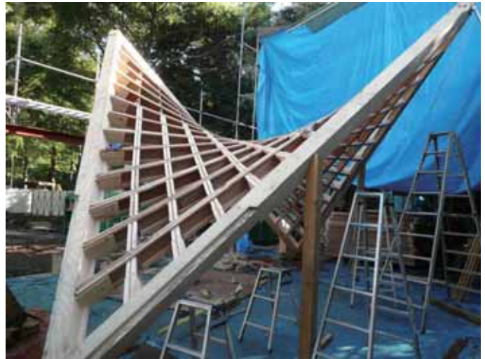
シェルの骨組製作 4辺の境界梁がLVL
