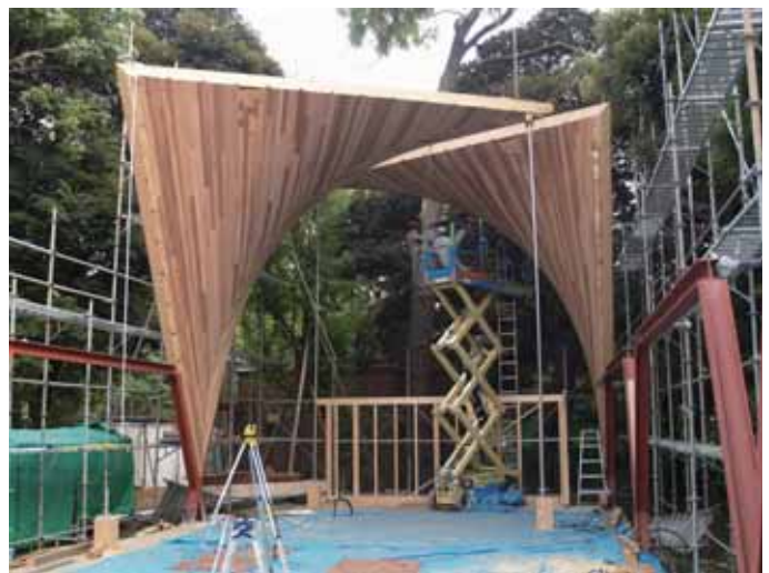
シェルの建て方
