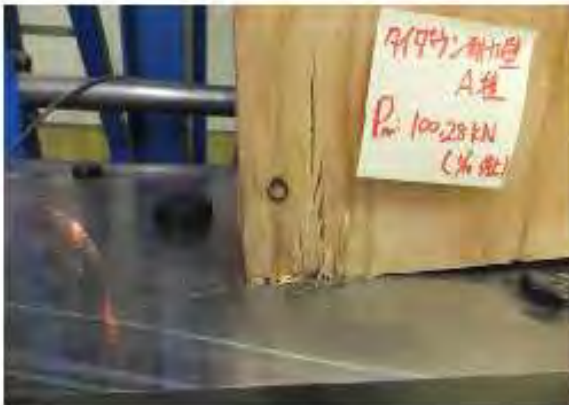
・加力側LVL壁の圧縮による亀裂。
