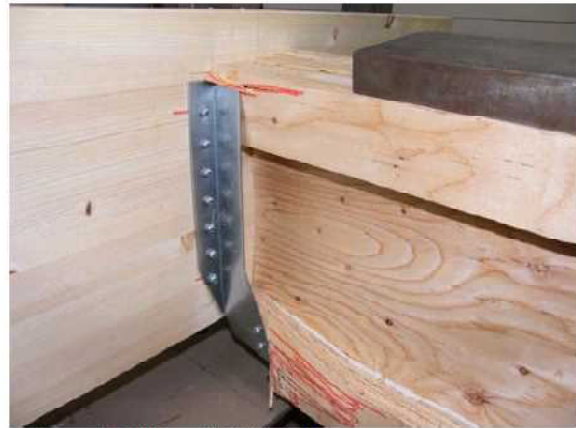
写真-4 破壊状況 試験体記号：MB-B-04 最大荷重：51.82kN ；破壊荷重：65.46 kN(40.0mm)
