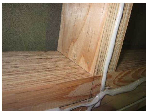
②束材とフランジ材の仮組み(造作用釘)
