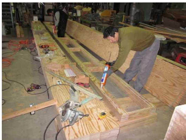
①フランジと束材の枠組みと接着材塗布
